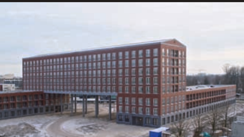
Breda-Chassépark, Het Paleis (Hans Kollhoff und Timmermann)
