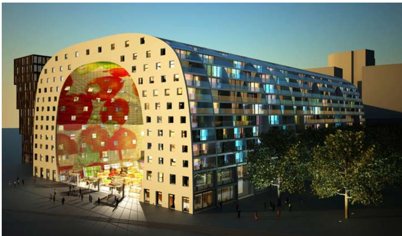
Markthal, Laurenskwartier Rotterdam (mvrDV)
