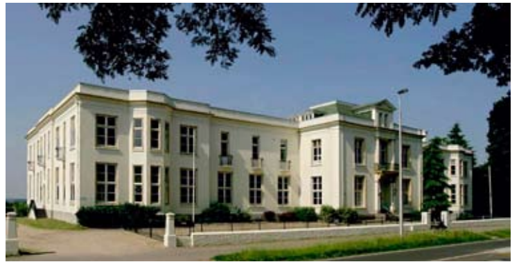
Rosorum, Arnhem (renovation: Van Ouwkerk Geesink Weusten)
