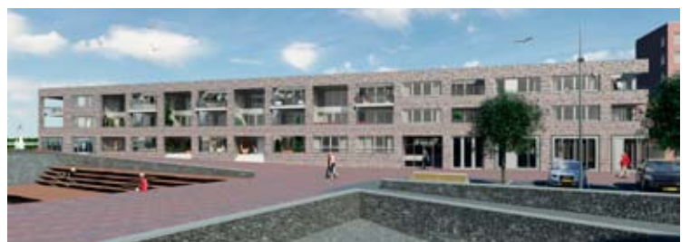
Tjalk (Block a), Steigereiland, Noordbuurt/Amsterdam (Marx & Steketeer Architecten)
